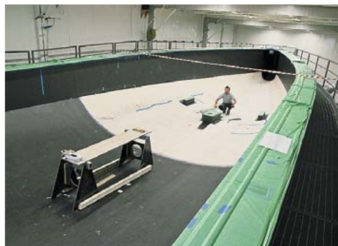
Il secondo scafo in costruzione per la Volvo Ocean Race SERVIZIO ZANCHI
